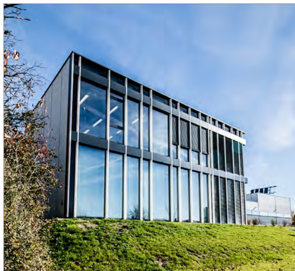
Das 2014 errichtete Forschungsgebäude „Energetikum“ am Campus Pinkafeld der Hochschule Burgenland bietet topmoderne Simulations- und Versuchsräume (Foto: Bubu Dujmic)
